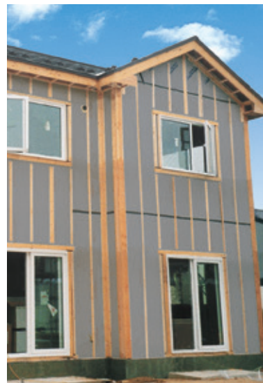
カネライトフォームスーパーEX 外張断熱施工例
